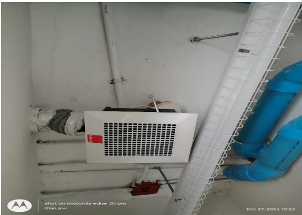
รูปที่ 3.3-6 พัดลมดูดอากาศในห้องขยะ
