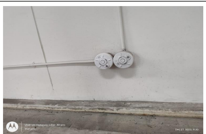
รูปที่ 3.8-10 เครื่องตรวจจับแก๊ส (Gas Detector)
